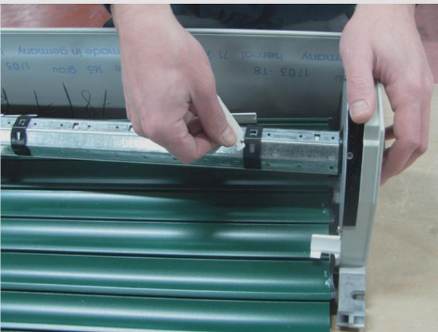
14. Obere und untere Endposition gemäß Bedienungsanleitung des Antriebes einstellen.
