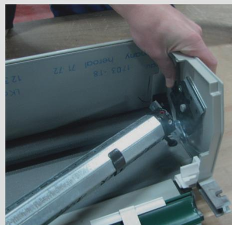
6.2 Motorkabel vorsichtig aus dem Kabeldurchlass des Rollladenkastens ziehen.
