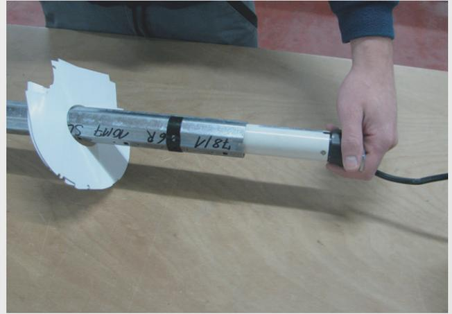
8. Den neuen Antrieb in die Rollladenwelle stecken. Hierbei die Nut am Motormittnehmer und den Falz der Rollladenwelle beachten!
